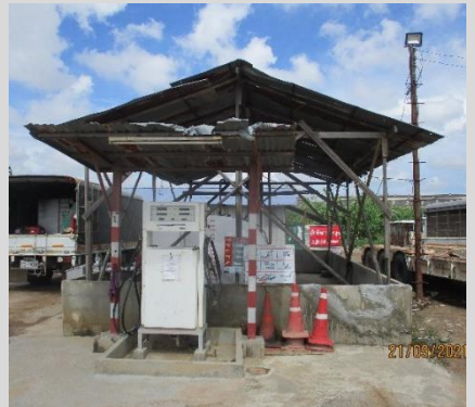
เทพื้นคอนกรีตยกขอบบริเวณที่เก็บน้ำมัน
