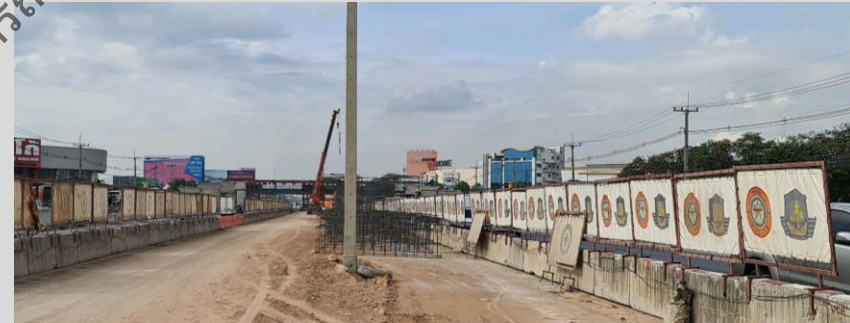
กำหนดเขตการก่อสร้างให้ชัดเจน
